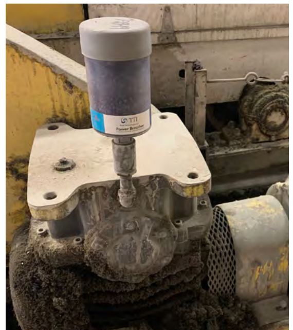
Figure 6. Filtre d'aération TTI installé
